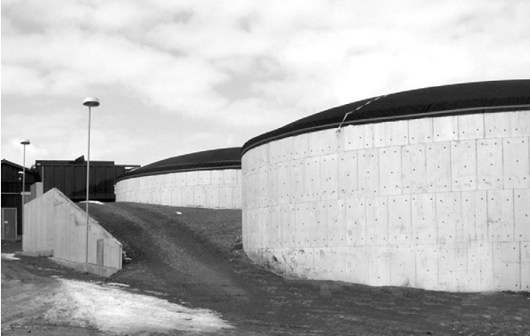
Una rampa di accesso posta a lato del digestore consente l'agevole inserimento di biomasse.
