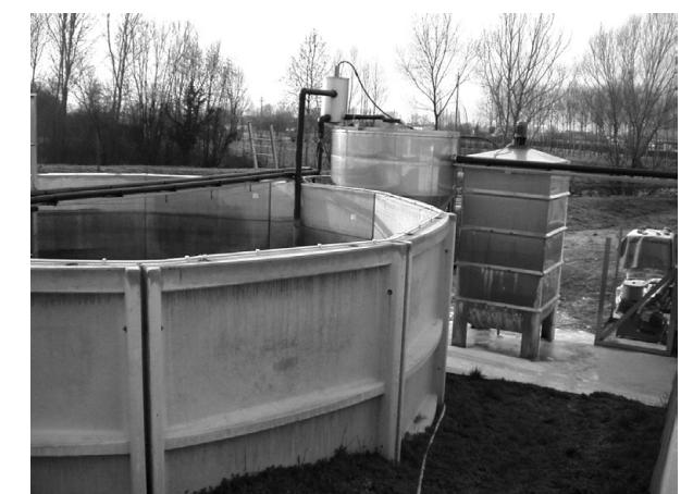
Un trattamento di separazione dei solidi fini per sedimentazione.
