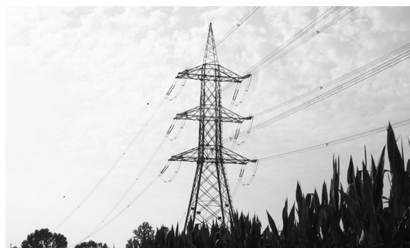
La cessione alla rete, per potenze superiori ai 50 kw, è di norma accettata solo in media tensione.
