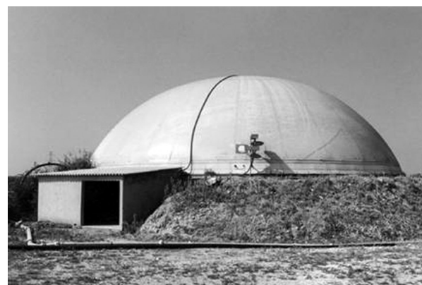
Il riporto di un terrapieno a lato del digestore rende più agevole l'accesso al digestore.
