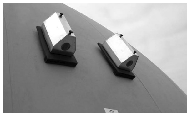
Speciali valvole tarate per la regolazione della pressione di lavoro della camera di compensazione.
