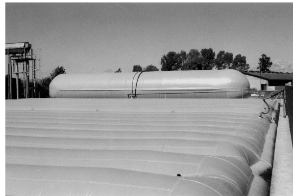
Il trattamento anaerobico può essere realizzato anche nei bacini esistenti grazie a speciali coperture galleggianti contrappesate ad acqua.
