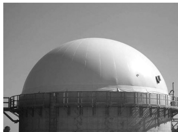
La predisposizione di idonee passerelle è essenziale per operare in sicurezza.
