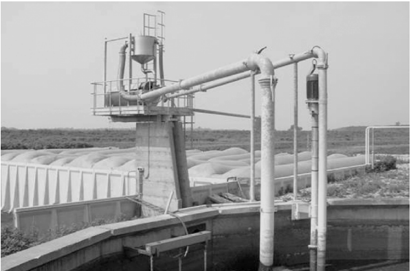
L'alimentazione del digestore con liquame fresco garantisce la massima produttività all'impianto.
