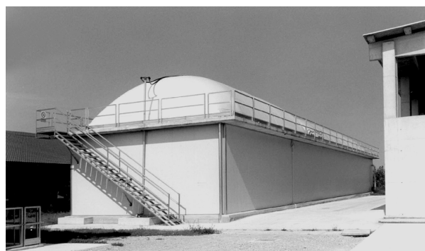
Un digestore "plug-flow" fuori terra con coibentazione esterna a cappotto per mantenere ottimale la temperatura di processo.
