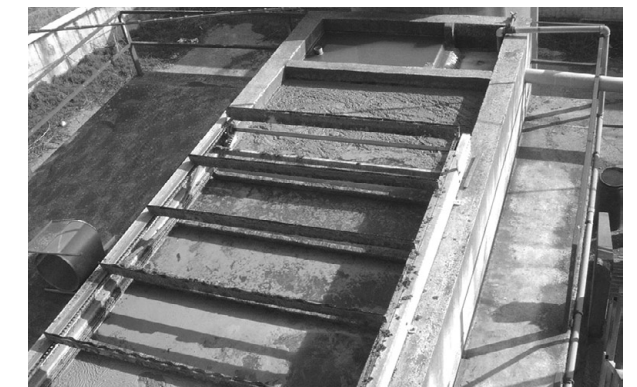
Il trattamento di flottazione permette di ottenere un liquame chiarificato e una frazione solida addensata.
