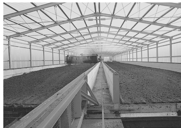
Gli impianti fissi di compostaggio consentono di ridurre considerevolmente i tempi del processo.
