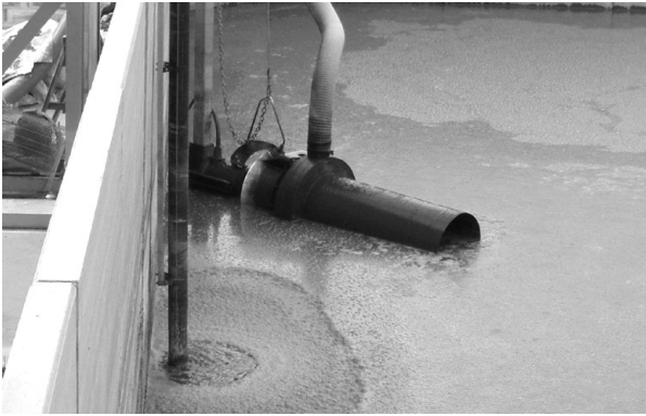
Speciale apparecchiatura per miscelare ed aerare la massa in funzione delle esigenze del processo "nitro-denitro".
