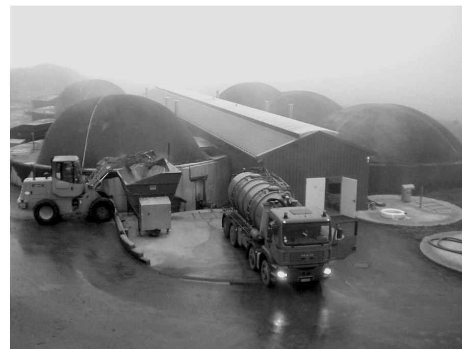
La cofermentazione di liquami zootecnici e di biomasse di origine vegetale ottimizza la produttività degli impianti.
