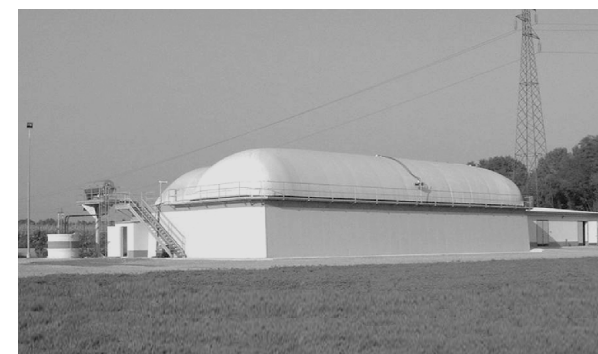
La disponibilità sul digestore di un notevole volume per lo stoccaggio del gas ne assicura un più razionale e completo utilizzo.
