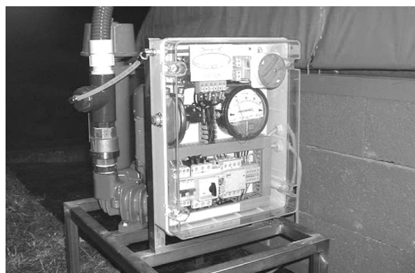
Centralina di controllo e regolazione del sistema gasometrico pressurizzato ad aria.
