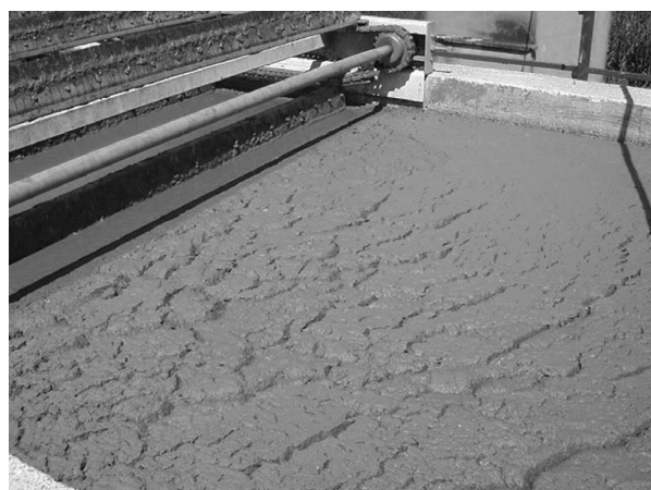
Il fango derivato dalla flottazione ad aria disciolta è facilmente digeribile e adatto per produrre biogas.
