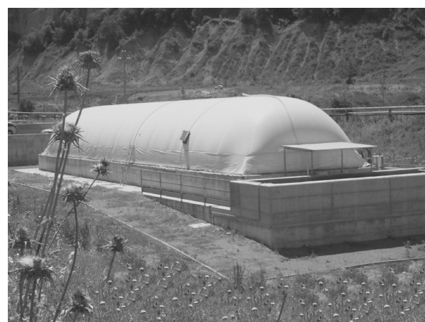
L'interramento del digestore, quando possibile, ne consente un più agevole controllo.
