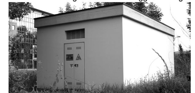
Le condizioni tecniche per la cessione dell'energia debbono essere concordate con l'ente distributore.
