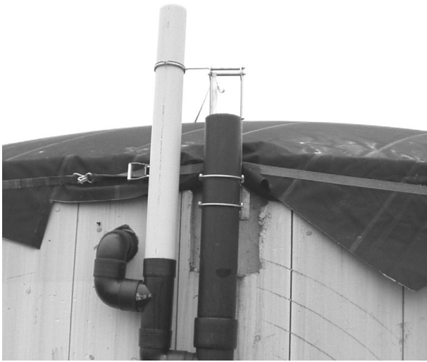
Particolare della valvola di sovrappressione del gas.
