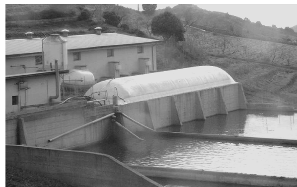
Lo stoccaggio del refluo stabilizzato anaerobicamente non pone particolari problemi relativamente alle diffusioni degli odori.
