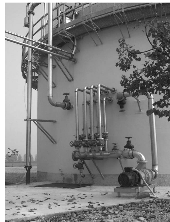
In presenza di modesti tenori di sostanza secca è possibile miscelare il digestore tramite il ricircolo della massa.
