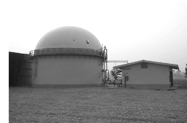
Digestore monostadio up-flow con cupola gasometrica pressostatica.
