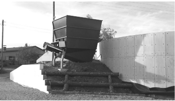
Tramoggia per dosare ed immettere la biomassa direttamente nel digestore.
