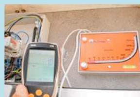
TEST DE ESTANQUEIDAD
